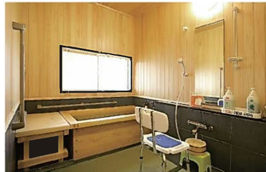
手すりを2箇所設置した浴槽
