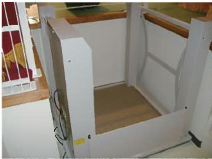
電動リフトの設置
