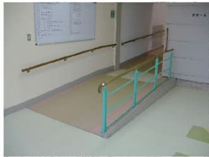
スロープの設置
