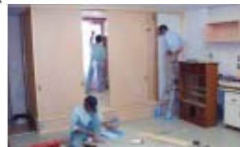
プライバシー確保のための間仕切り製作
