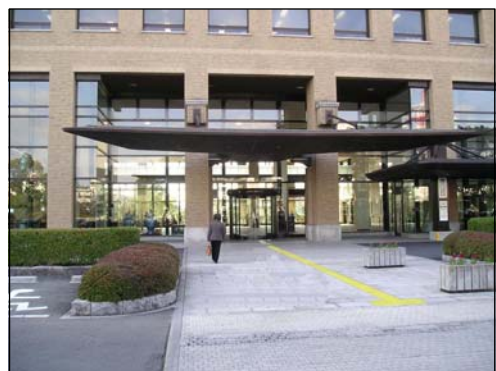
誘導用ブロックの色を黄色にする例。花壇を撤去する例
